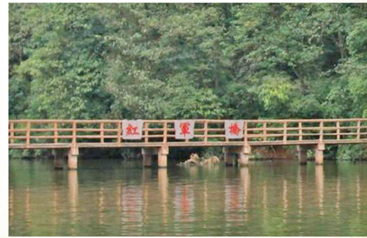
红军伤员伤愈离开四面山前夕，为了感谢老乡救命之恩，在洪海村通往山外道路涉水而过的溪涧上修建了一座木质便桥，以保障乡亲们过往安全。解放后，此桥被命名为红军桥。
