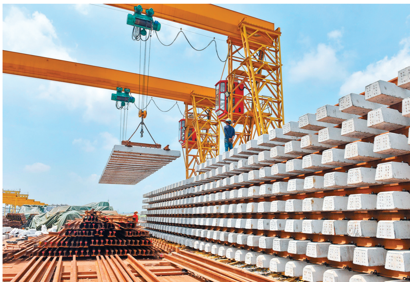
工人正在进行吊装作业 记者 贺奎 摄
