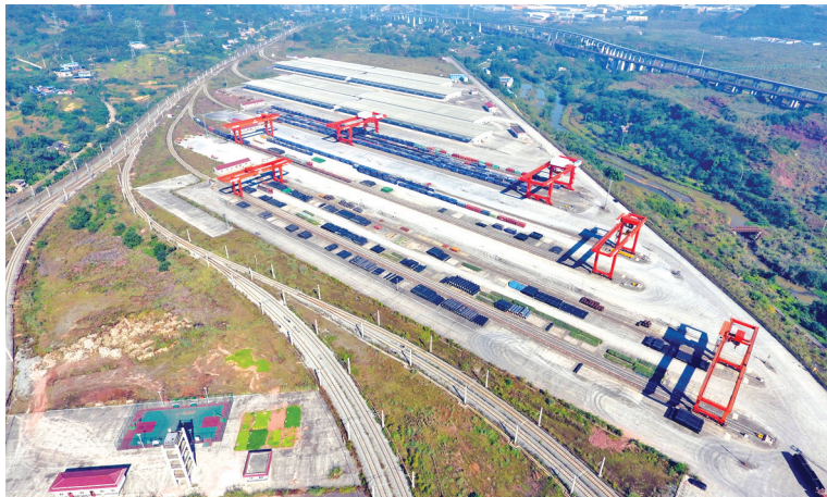
珞璜铁路综合物流枢纽
