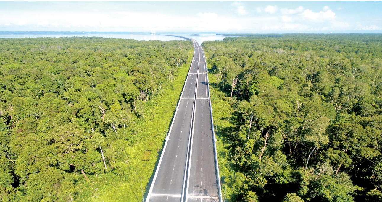
文莱淡布隆跨海大桥通车 中建桥梁供图
