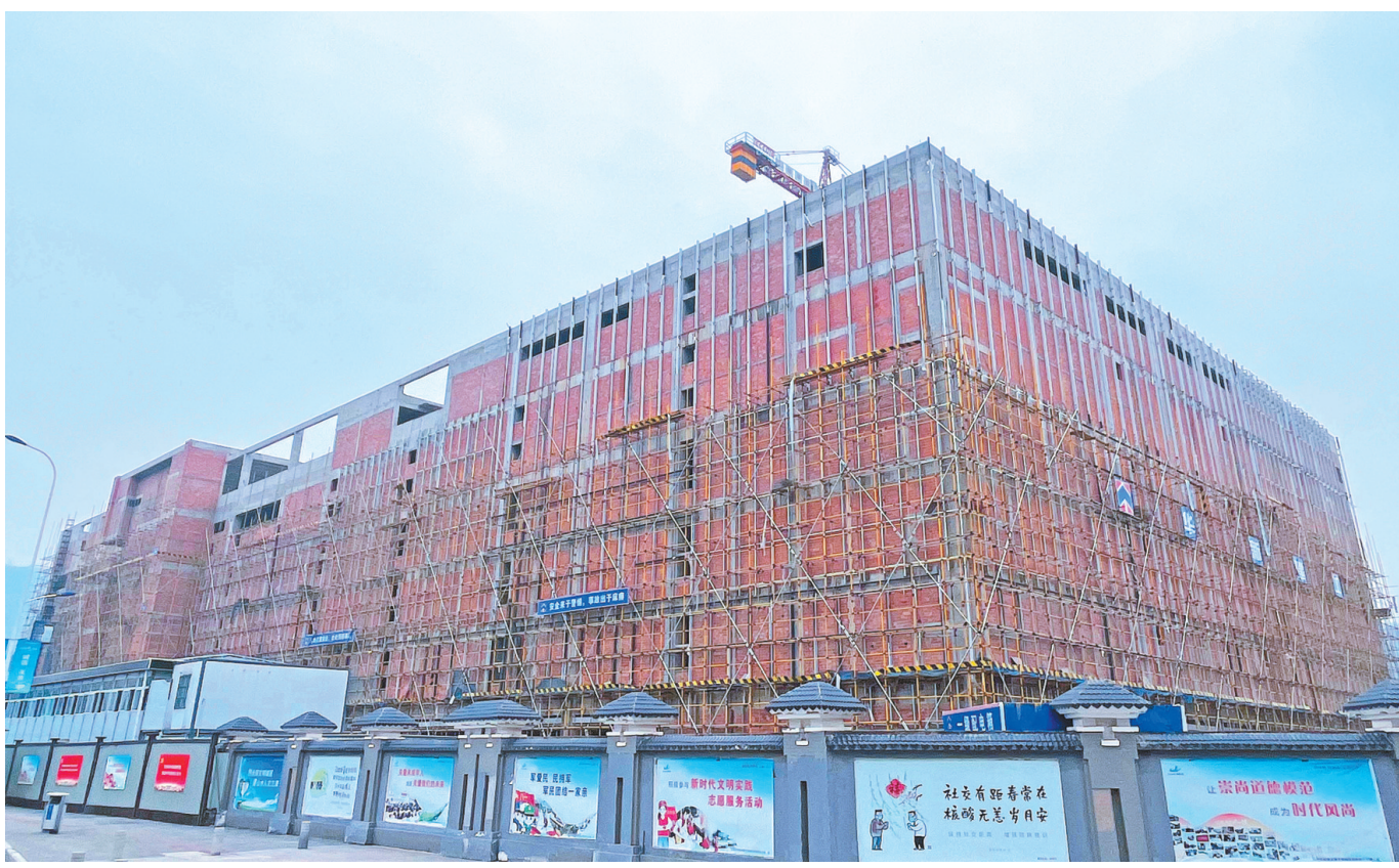
重庆敏华家居商场项目施工忙 记者 廖洋 摄
