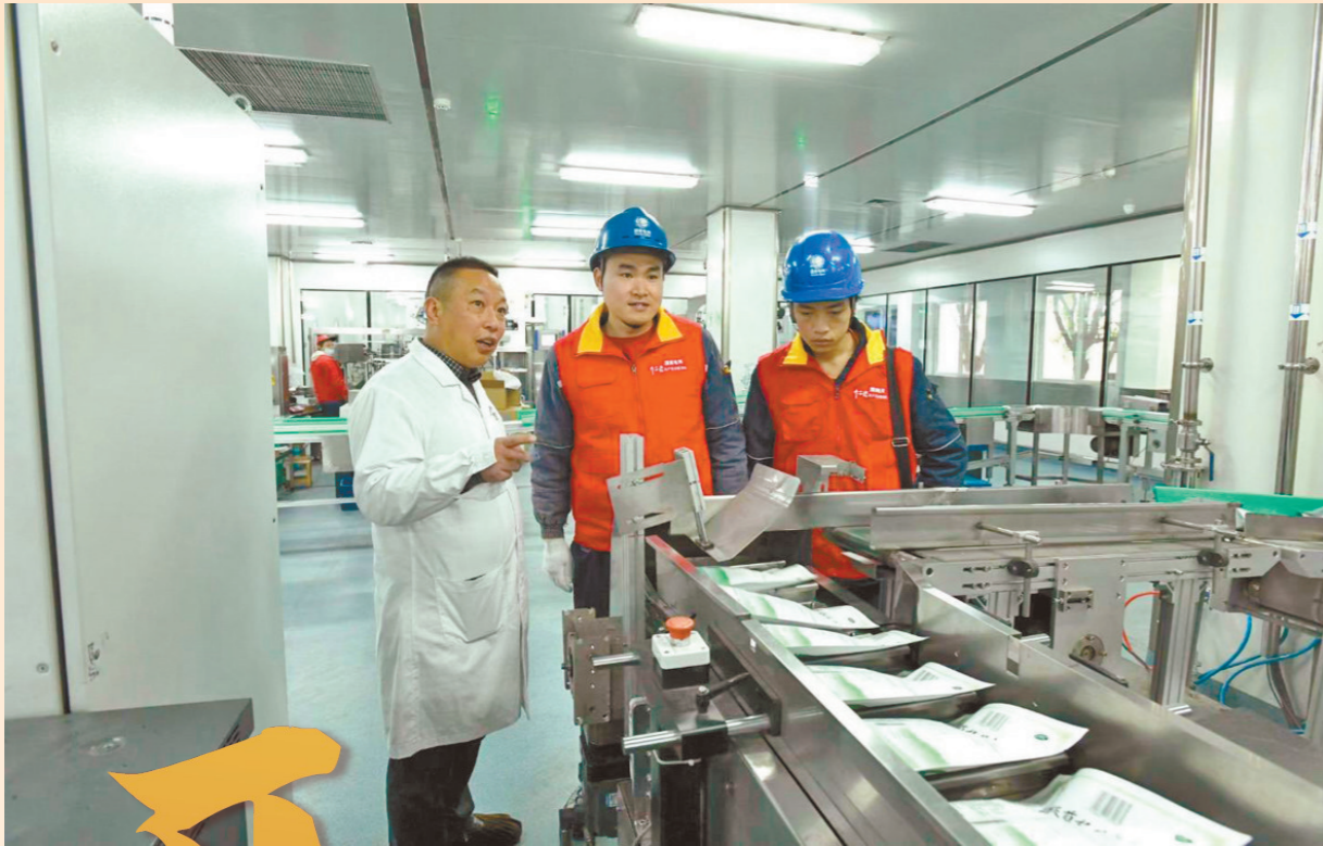
昨日，国网江津区供电公司圣泉供电所员工来到德感工业园重庆中药二厂开展用电安全检查，助力企业生产。通讯员 王化全 摄
