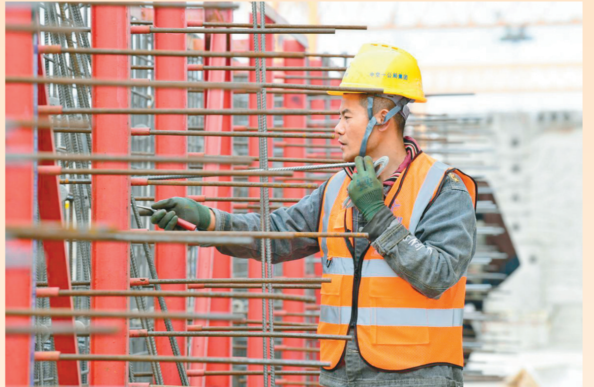
昨日，中交一公局集团重庆江沪北线一分部项目工地上，工人们正在加紧施工捆扎T梁钢筋，以饱满的热情积极投入工作中，推动项目加快建设。记者 苏盛宇 摄
