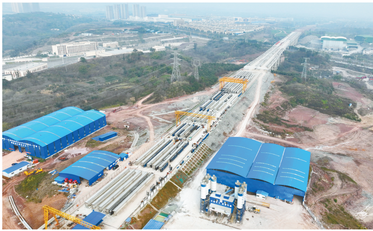
江沪北线施工现场 记者 苏盛宇 摄
