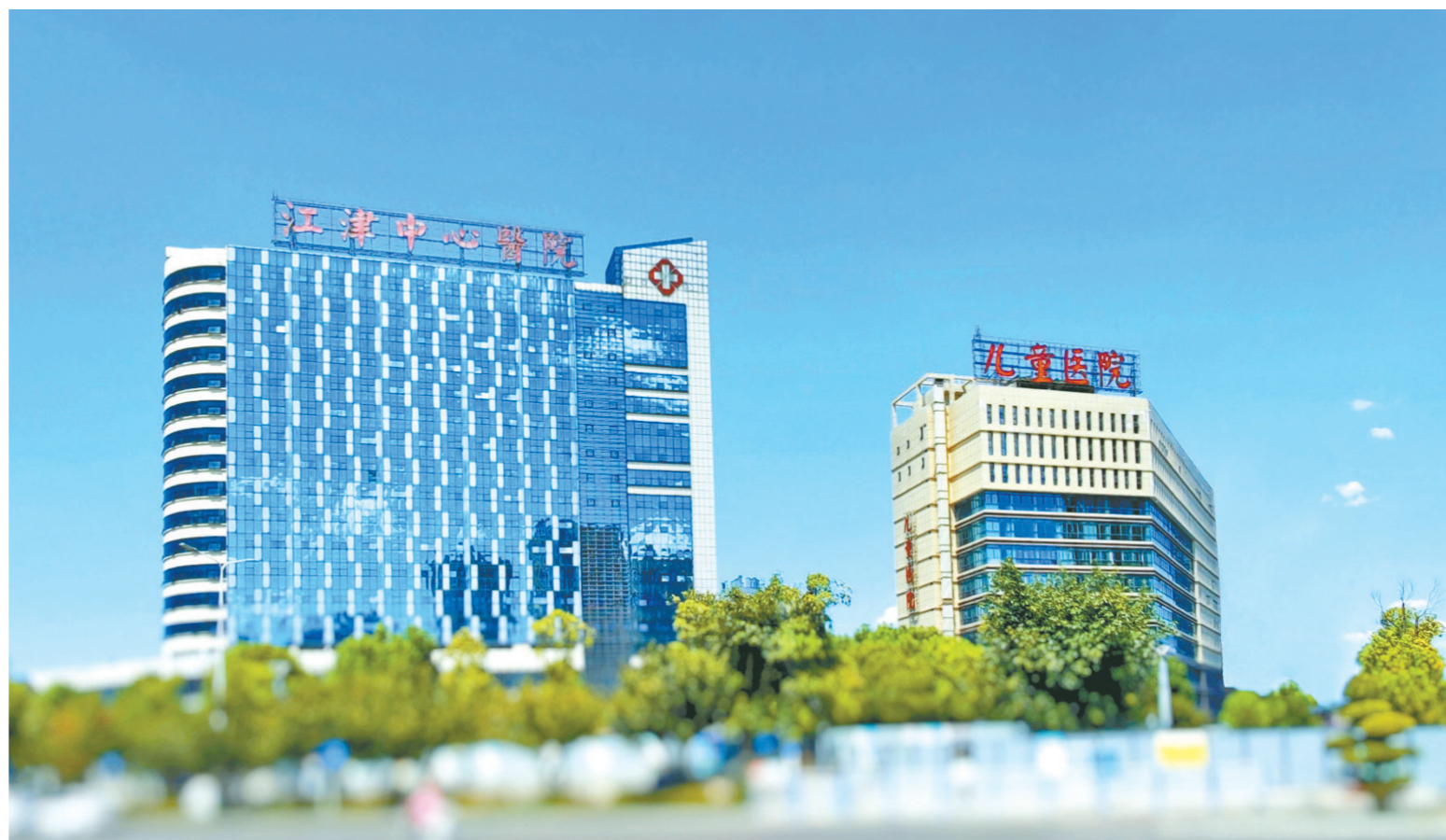
医院医技大楼
