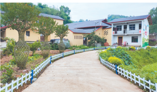
整治后的杜市镇龙凤村四方井示范院落
