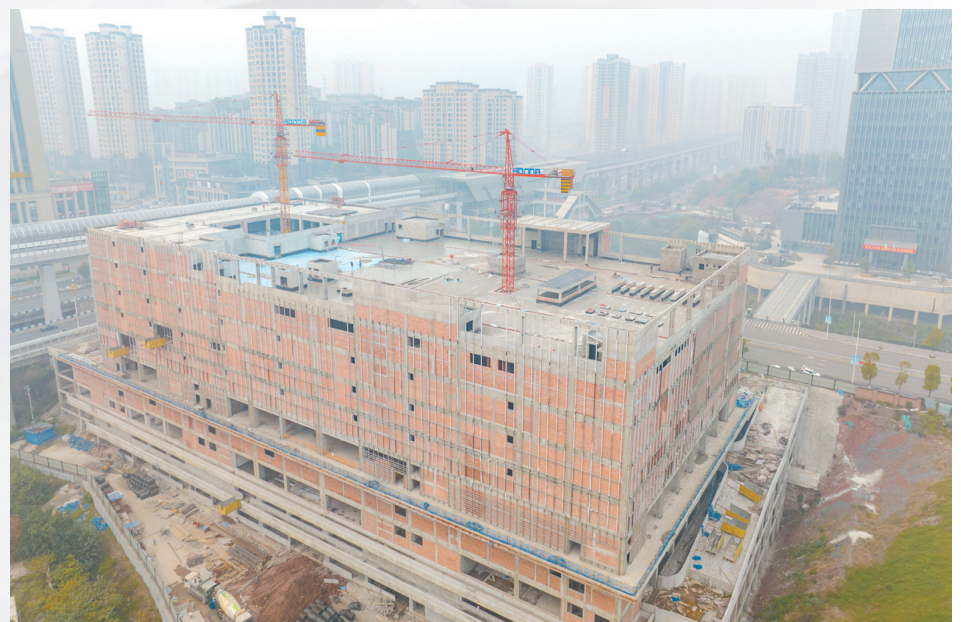
11月，重庆敬华家居商场完成主体结构封顶，预计2023年建成投用。李家湾隧道项目动工建设，该项目将与浒溪北路连接贯通，为滨江新城交通路网再添助力。
