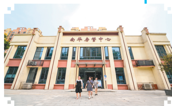
公租房小区内的房管中心
