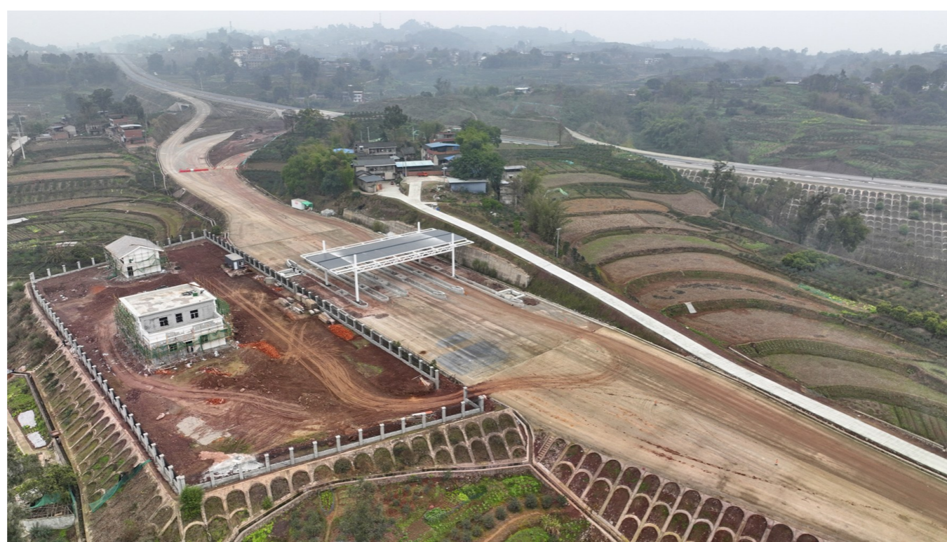
合璧津高速龙华下道口施工现场 记者 康东年 摄
