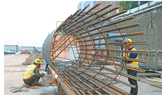
工人们正在绑扎钢筋 记者 苏盛宇 摄
