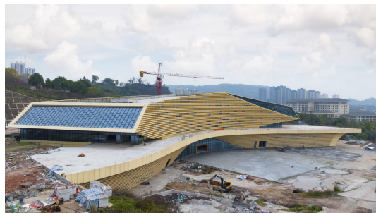
新城荟项目建设现场 记者 廖洋 摄
