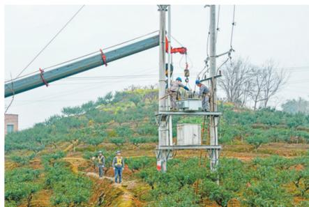
日前，国网江津区供电公司在油溪镇吴市社区试点安装的容量为100千伏安宽幅调压变压器投入运行。据了解，该变压器是国网江津区供电公司根据农网配电网特点，与国网重庆电力电科院合作，设计开发的农网专用宽幅调压变压器，提高了稳压能力和供电质量，为附近68户椒农烘烤花椒期间用电提供保障。
