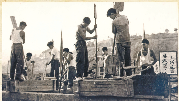
三五三三工厂工程建设热火朝天的景象
