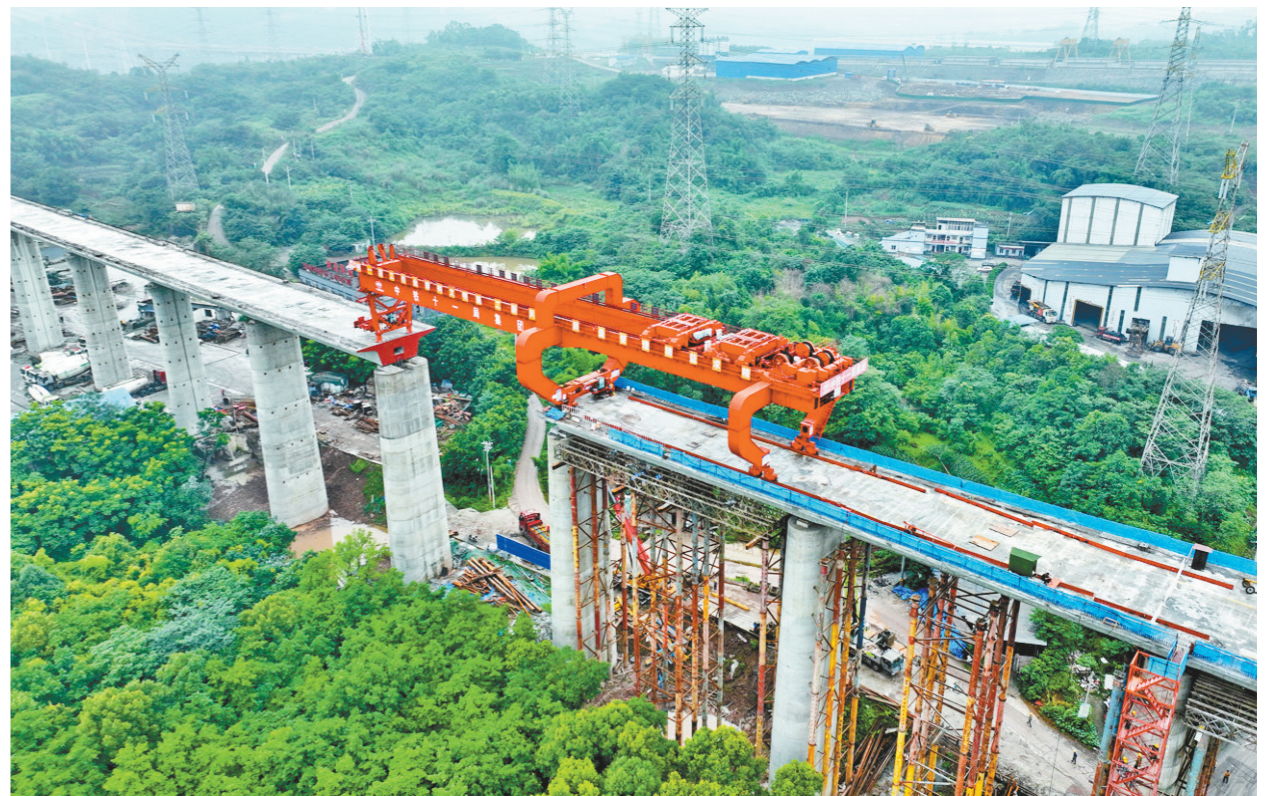
6月18日，渝昆高铁江津双福段，大桥最后一段正在合龙施工 贺宝胜 摄
