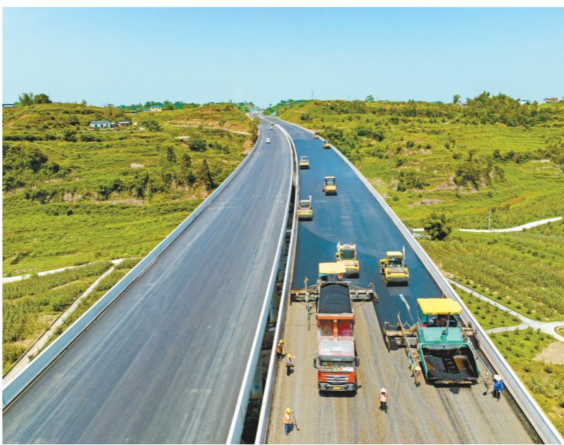
江泸北线高速沥青摊铺现场 通讯员 王勇毅 摄
