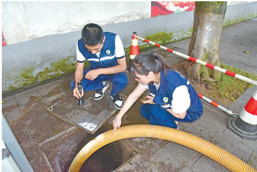
区住房城乡建委对管网疏浚情况进行核查 记者 施婉莹 摄
