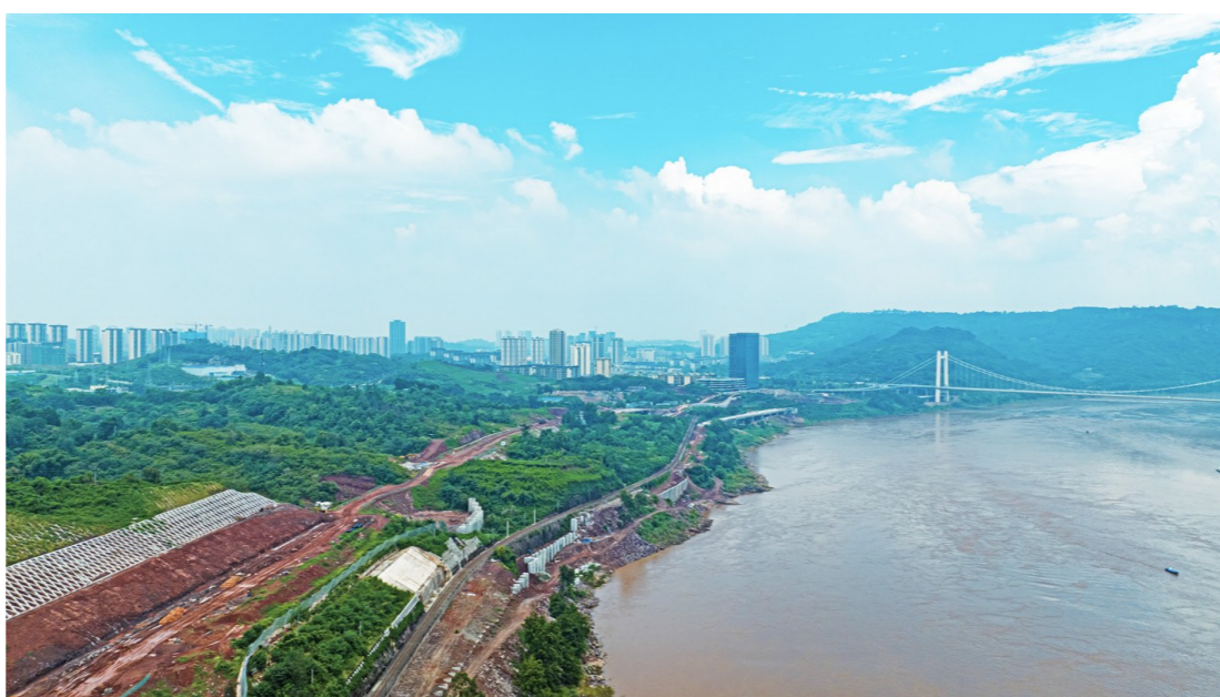
德滨路东段一期项目施工现场 记者 廖洋 摄
