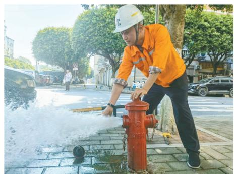
水管工检查辖区内市政消防栓出水压力
