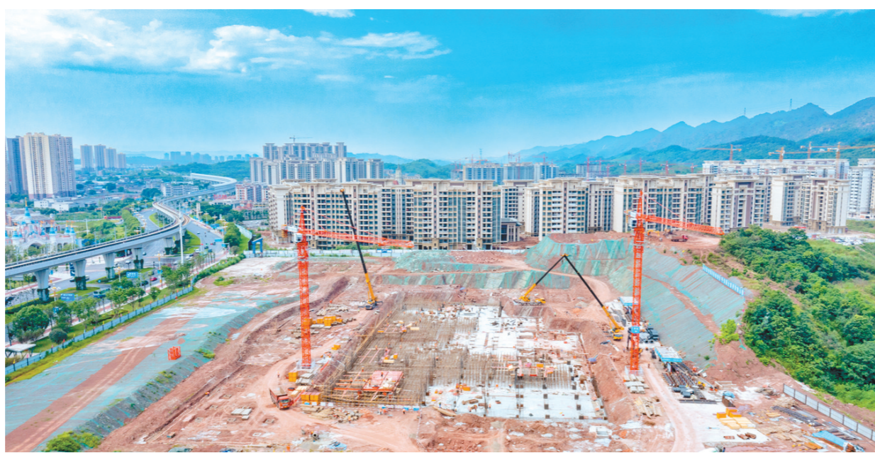
区妇幼保健院新院区项目建设现场 记者 廖洋 摄
