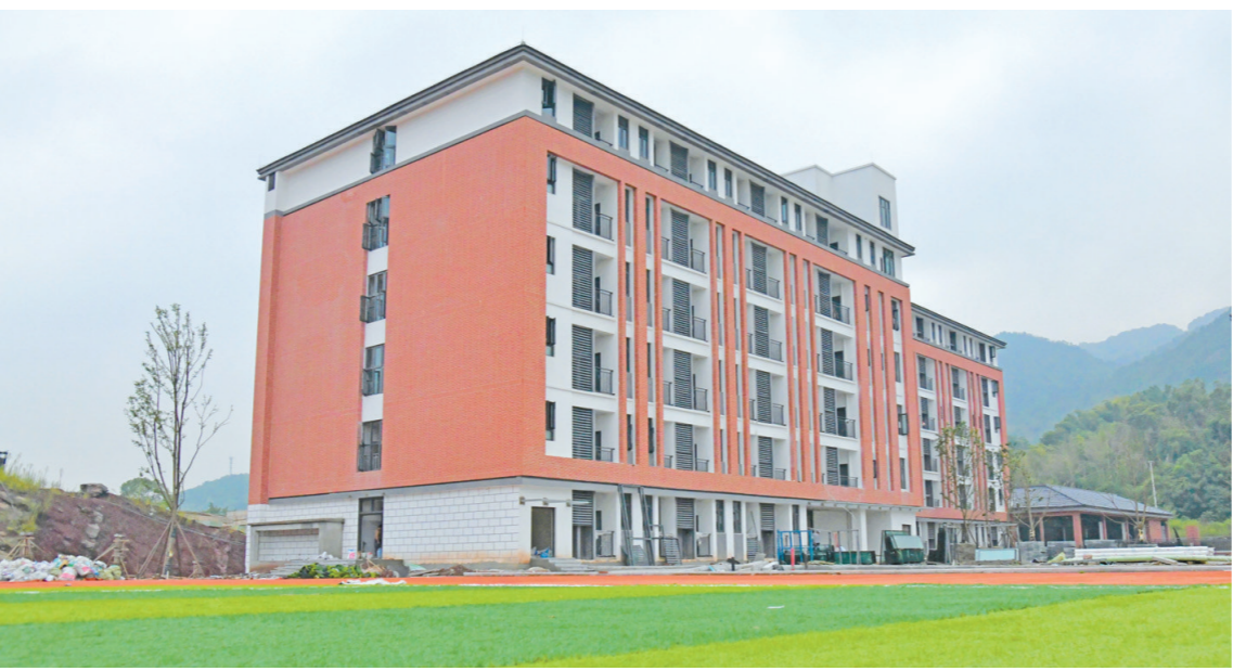
即将建成投用的双福二中 记者 廖洋 摄
