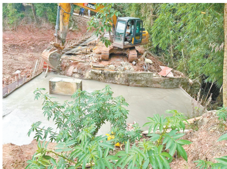
施工现场 白沙镇供图
