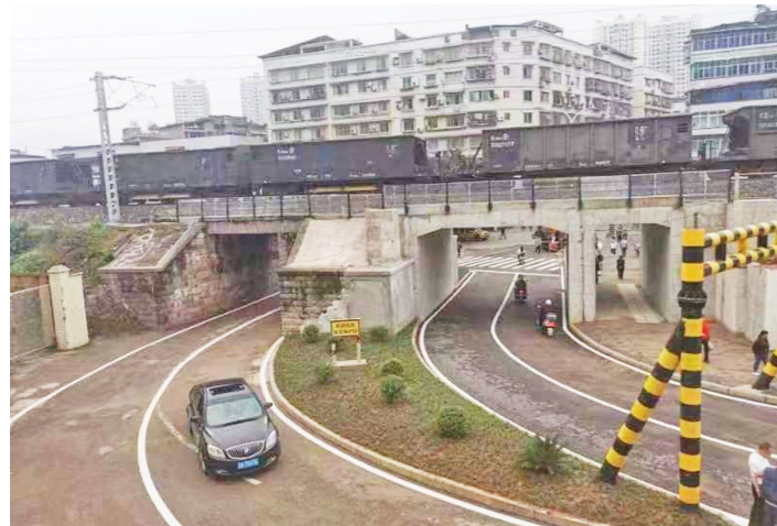
成渝线K421+025下穿通道 油溪镇供图
