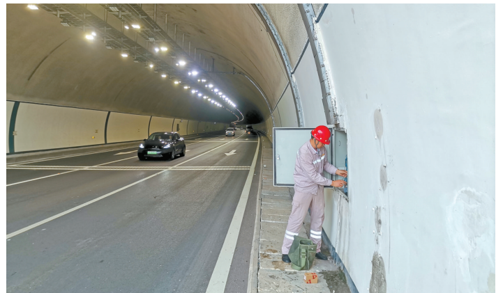
隧道照明智能升级改造现场 区城市管理局供图
