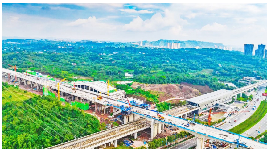
渝昆高铁江津北站综合交通枢纽项目已进场施工 记者 廖洋 摄
