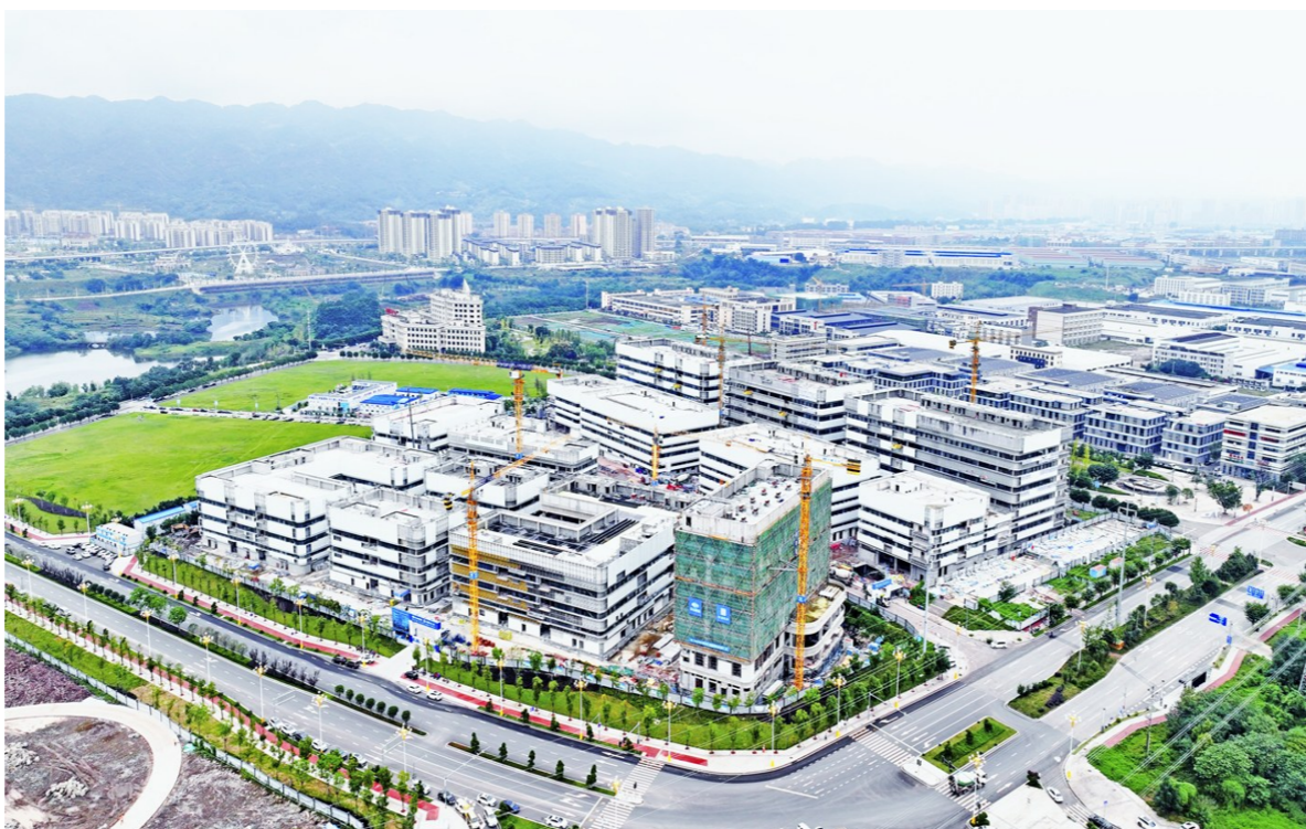
团结湖数字经济产业园PPP项目 记者 廖洋 摄
