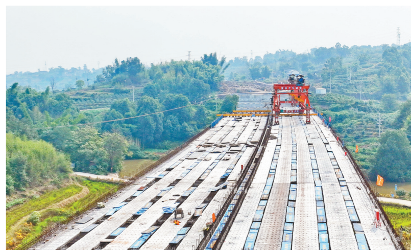
永津高速陈家祠堂大桥T梁架设现场 记者 苏盛宇 摄
