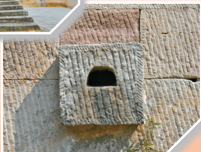
墙上的排水口
