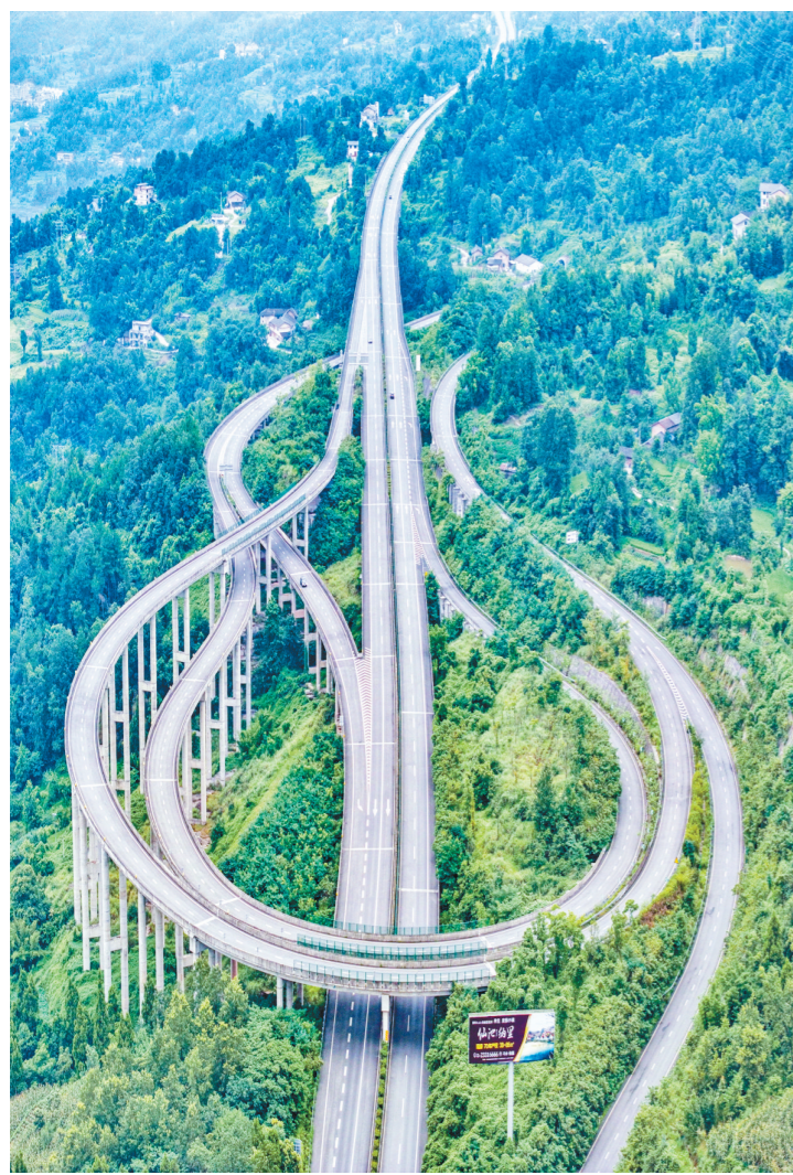
9月28日，俯瞰中的江习高速像一条巨龙不断伸展，带动一方产业发展。 谭文奇 摄
