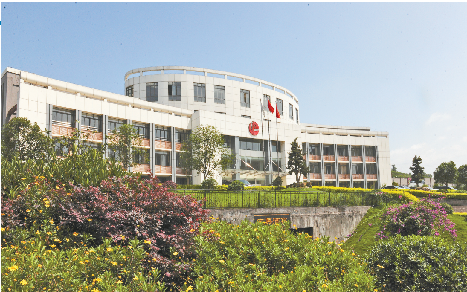
江津酒厂办公大楼
