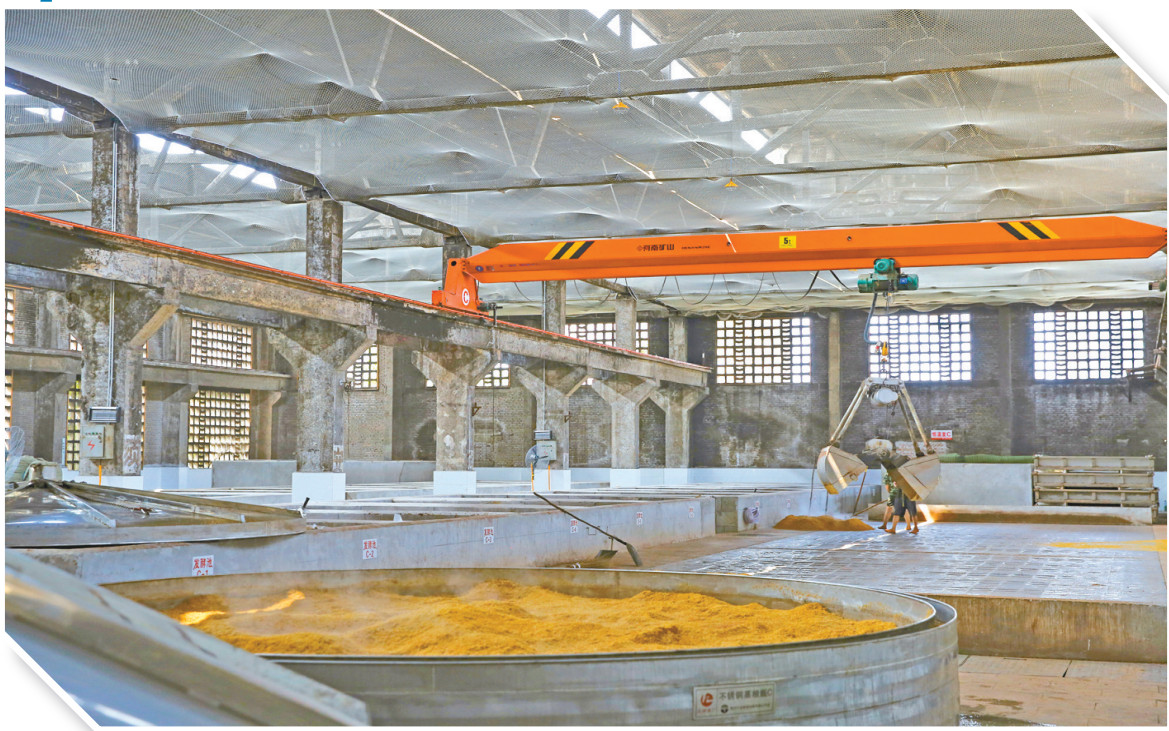
技改后的新车间
