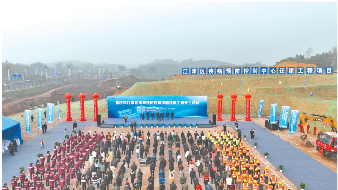
区疾控中心项目开工 记者 康东年 摄
