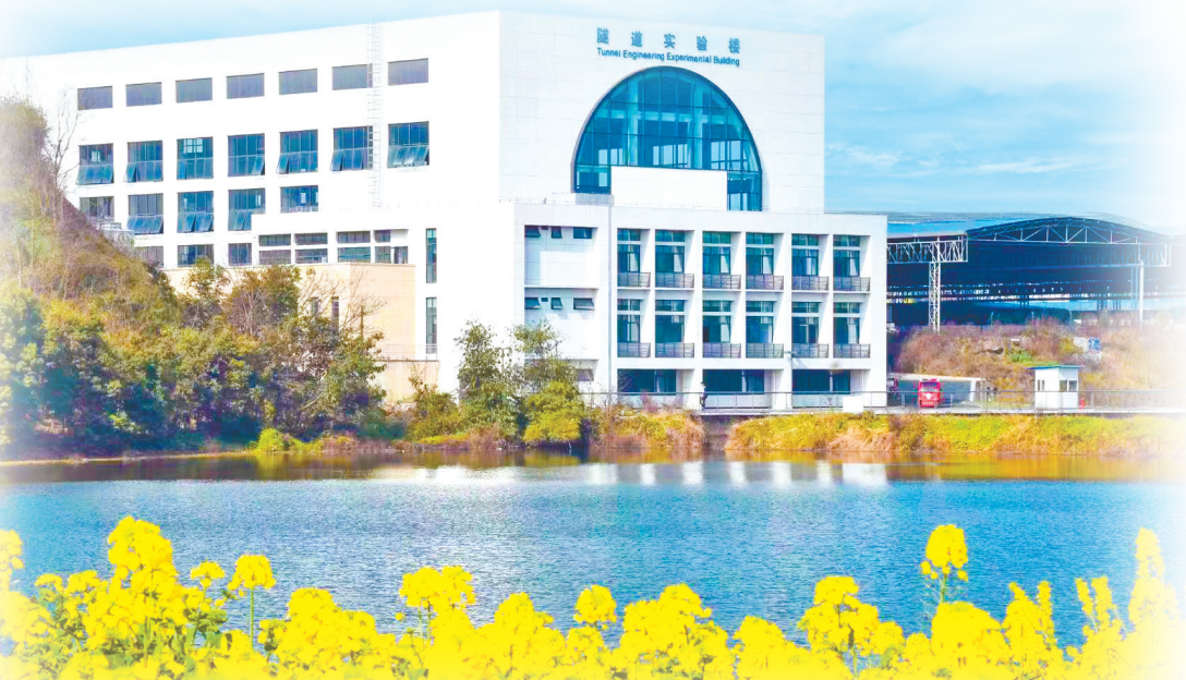
重庆交通大学山区桥梁及隧道工程国家重点实验室
