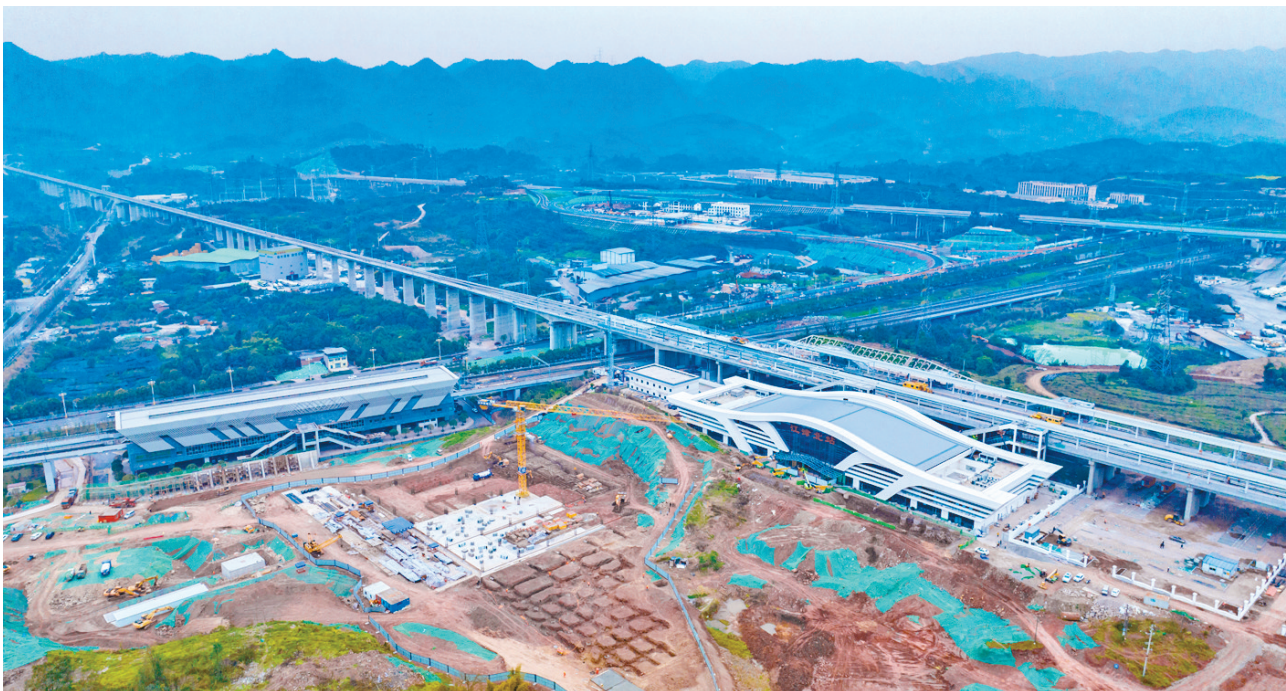
渝昆高铁江津北站建设现场 记者 廖洋 摄
