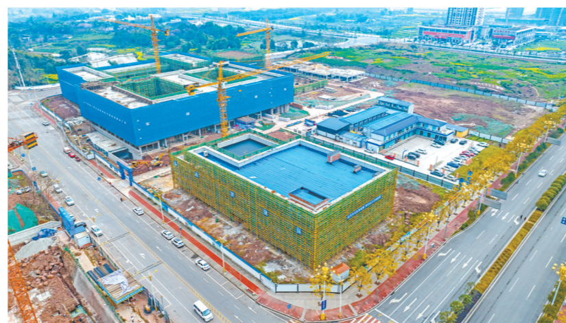
项目建设现场 记者 廖洋 摄
