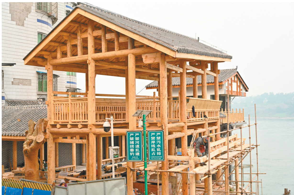
风雨长廊施工现场 记者 吕晓梅
