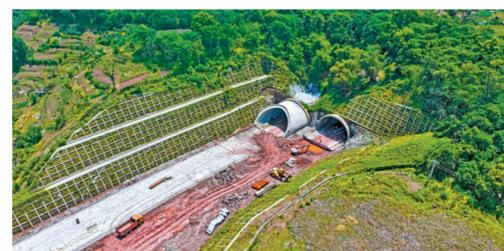
昨日,记者从滨江新城建设管理中心获悉,李家湾隧道左洞贯通。至此,李家湾隧道左右双洞全部贯通,预计7月完成建设。李家湾隧道道路工程南起松林路,止于规划10号路,道路全长约500米,双洞双向六车道。图为建设中的李家湾隧道。
