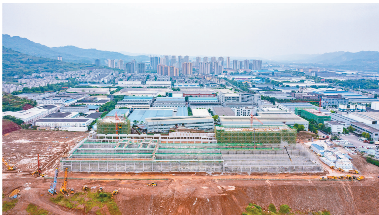
威马二期项目建设现场 记者 刘星欣 摄
