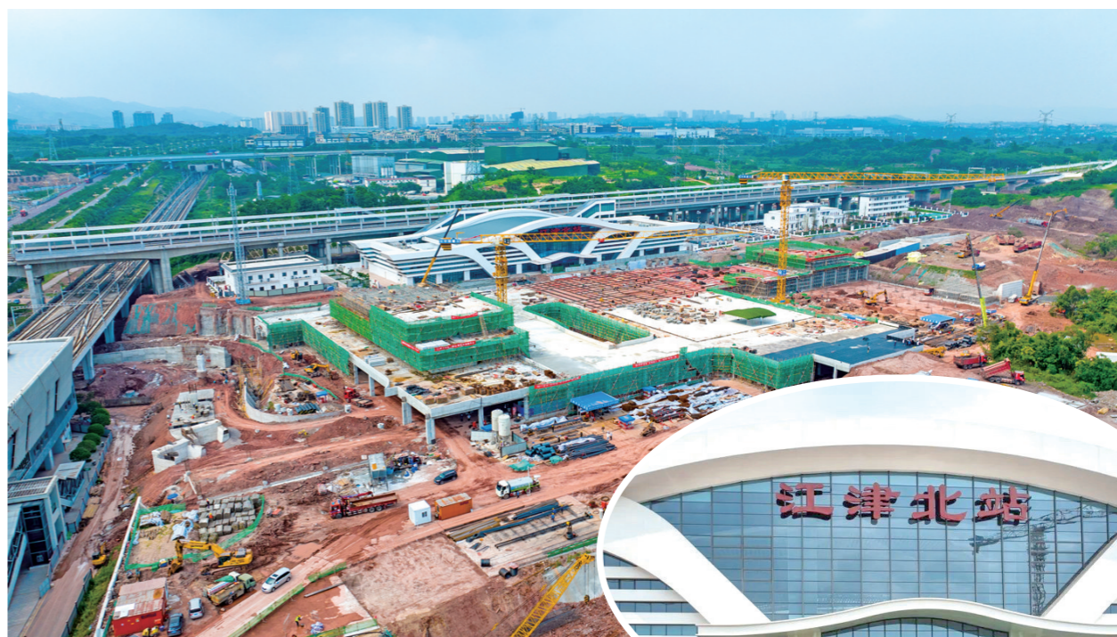
渝昆高铁江津北站综合交通枢纽配套基础设施项目建设现场 记者 廖洋 摄
