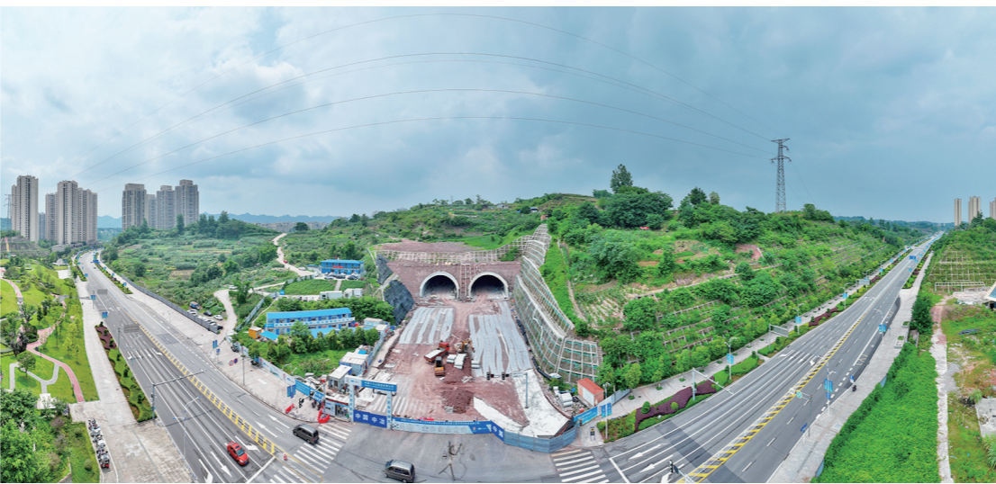
李家湾隧道项目建设现场 记者 廖洋 摄
