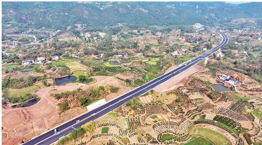
永津高速公路项目正在抓紧建设 记者 苏盛宇 摄
