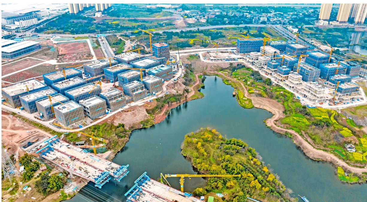
团结湖数字经济产业园建设现场 记者 廖洋 摄
