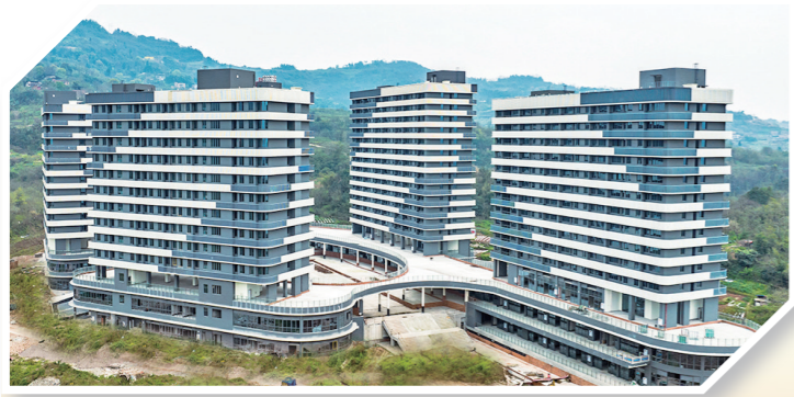
重庆枢纽港产业园（江津片区）农民工公寓
