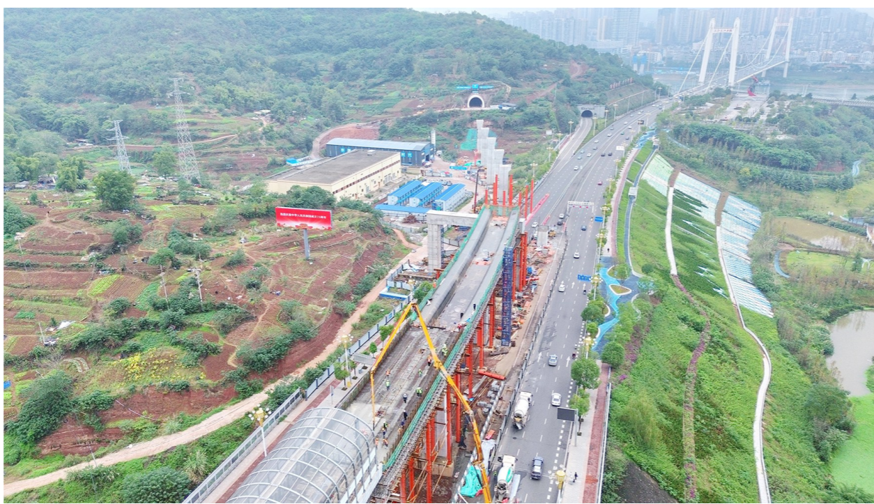
市郊铁路江跳线过江段首跨箱梁浇筑现场
