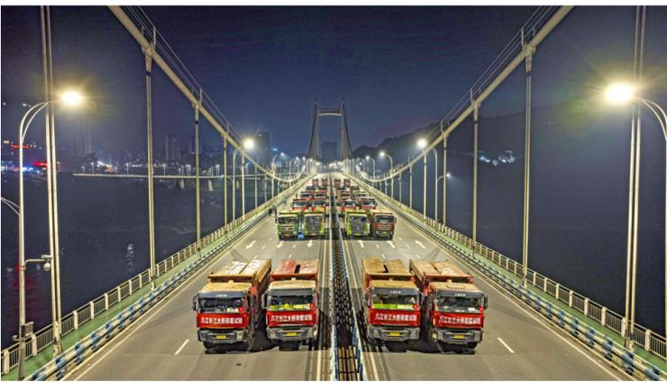
本报讯(记者 胡耀方 通讯员 吴宜言)11月28日凌晨2时,几江长江大桥荷载试验有序进行。48辆载重共1680吨的加载车分4次加载,最终稳稳停在几江长江大桥的桥面上。
