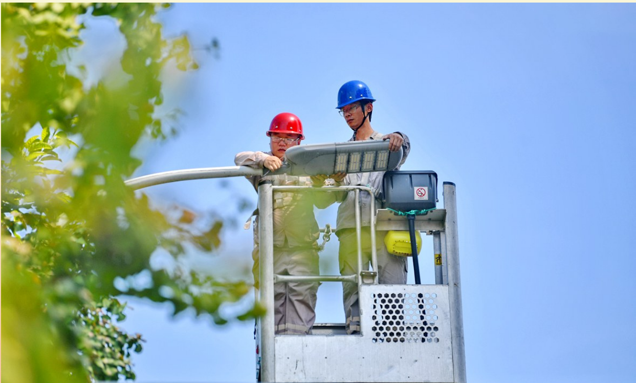
2024年8月27日，为了保障城区重要道路交通照明，区路灯管理所工作人员在烈日下维修LED节能路灯。
