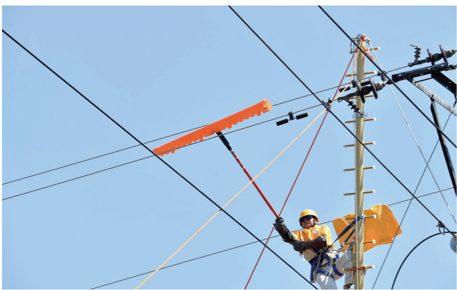
▲ 2024年5月13日，石蟆镇东溪村，国网重庆江津供电公司员工首次采用绝缘“蜈蚣梯”开展带电搭接引流线。
