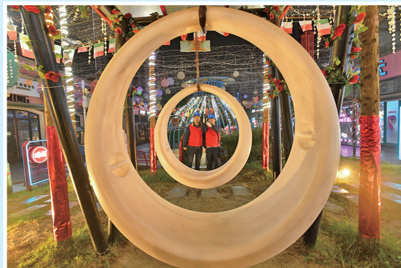
2024年2月6日晚，在双福新区对灯饰用电开展特巡，及时消除安全隐患，让人民群众度过一个欢乐、祥和的新春佳节。
