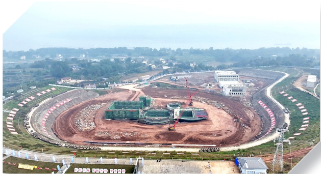
渝西水资源配置工程东干线占渝西工程总供水量的30%
