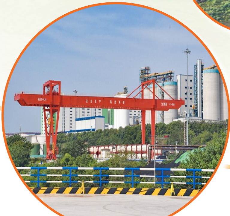
重庆港江津港区兰家沱作业区一期改扩建工程竣工投用
