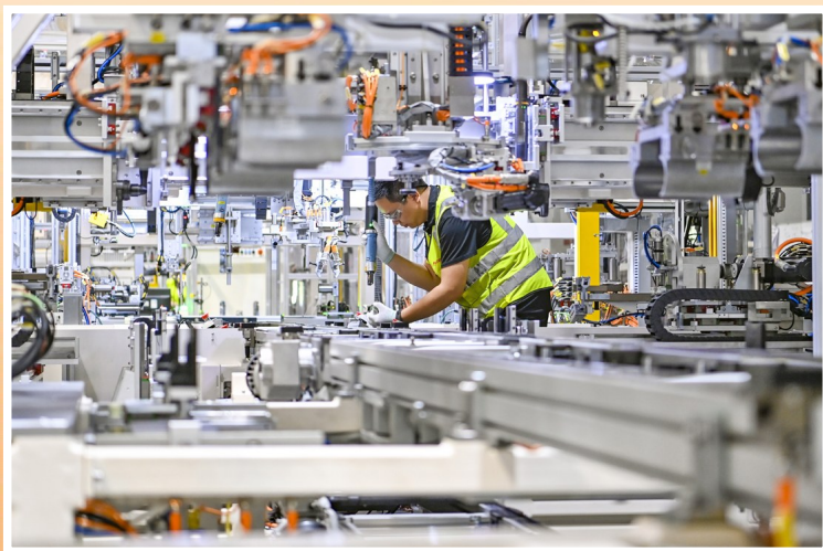
重庆耐世特REPS生产基地项目正在进行设备调试
